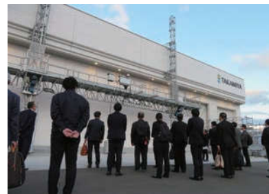
最大幅32m、高さ210mまで対応可能という電動の移動昇降式足場
